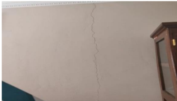
Gambar 3. Kondisi Dinding Retak
