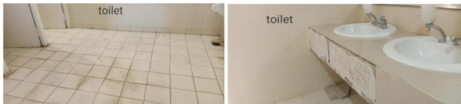
Gambar 5. Lantai Toilet Licin Dan Retak
